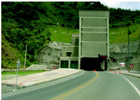
Túnel del Occidente Antioqueño
